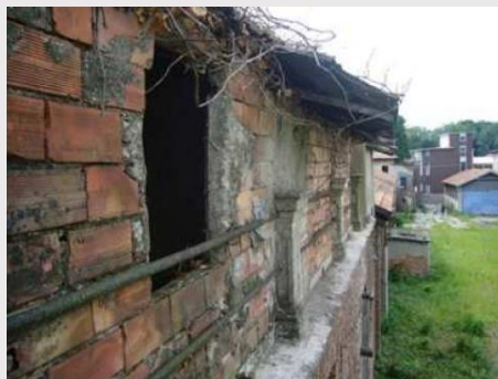
Il manufatto costruito sopra la terrazza a est è pericolante e verrà demolito
